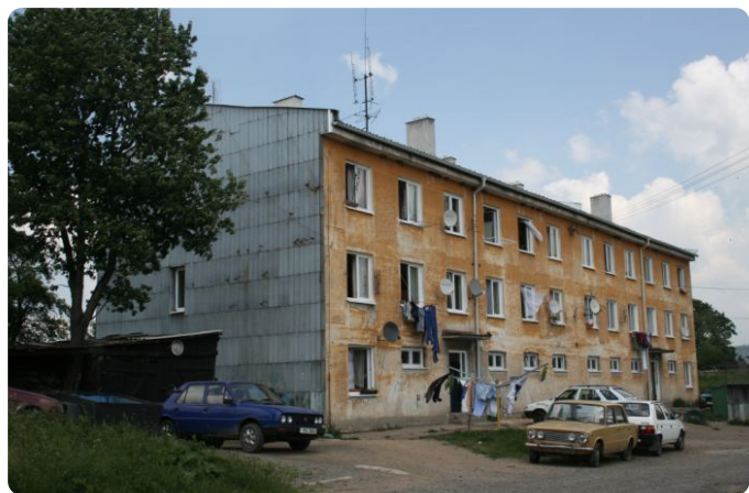
1. Prostor před panelovým domem
